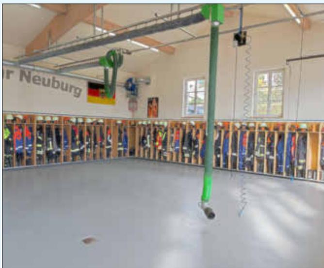
Das Feuerwehrgerätehaus in Neuburg hat einen neuen Bodenbelag erhalten. Der alte Boden aus dem Jahr 1990 war mittlerweile stark in Mitleidenschaft gezogen und nicht rutschhemmend. Nun wurde durch eine Fachfirma eine für Feuerwehrgerätehäuser vorgeschriebene Beschichtung aufgebracht.
