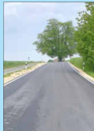
Die Bauarbeiten zur Sanierung der Asphaltdeckschicht auf der Ortsverbindungsstraße Neuburg-Wattenweiler sind mittlerweile abgeschlossen. Die alte Deckschicht wurde abgefräst. In einigen Bereichen wurde auch der Unterbau der Straße erneuert. Die vorhandenen Regenrinnen konnten im Rahmen der Bauarbeiten allesamt erhalten werden.
